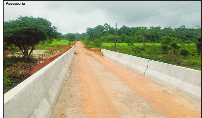
Mesmo em período crítico das chucas, obras estão a todo vapor em Apicás
