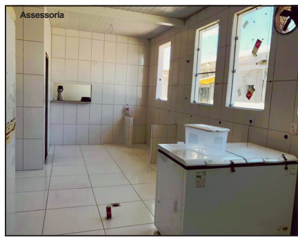
Obras do hospital no município de Apicás
