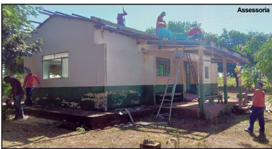
Unidade Básica de Saúde recebe obras de melhorias
