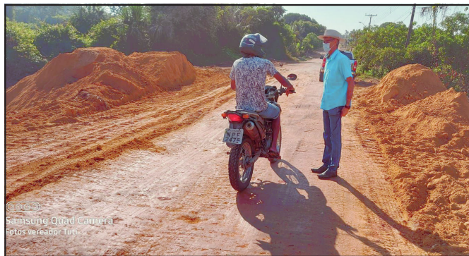
Aduelas foram implantadas, mas ainda resta a conclusão da obra
