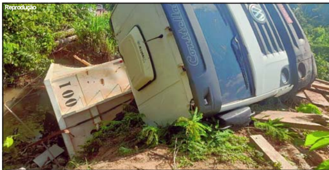
Caminhão estava carregado de pedra quando ponte quebrou
