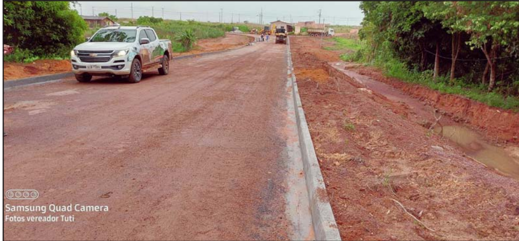
Obra realizada em Alta Floresta é de mais de 20 mil metros quadrados no bairro Vila Nova
