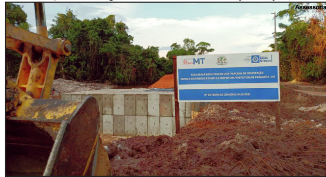
Obras com aduelas são feitas em parceria com o estado
