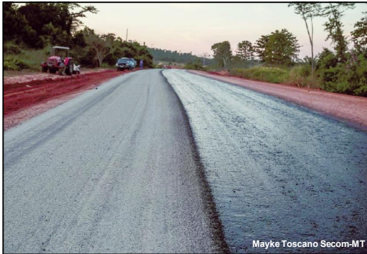
Obra de pavimentação da MT-206 entre Paranaíta e Apicás
