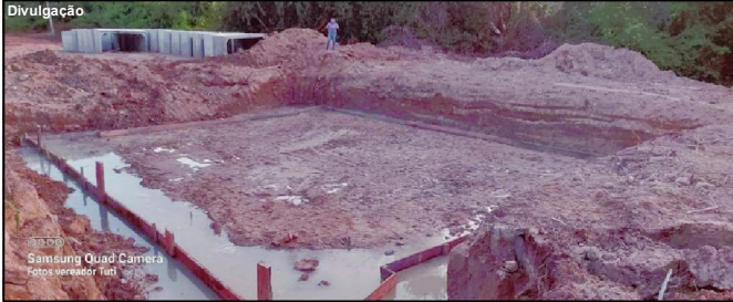
Obra em execução na zona rural de Alta Floresta
