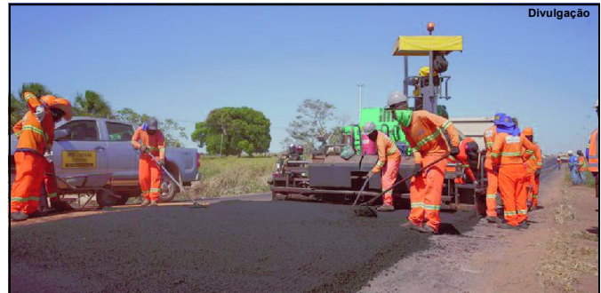
Empreiteira com prazo para cumprir projeto, mas falta de mão de obra pode comprometer
