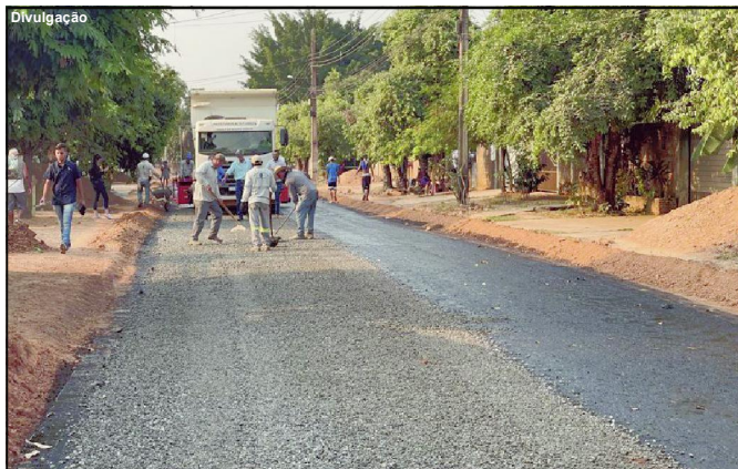
Prefeito acompanhando fase de conclusão da obra em AF
