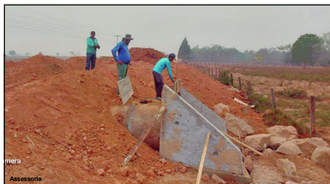
Obra executada na Primeira Norte, em AF
