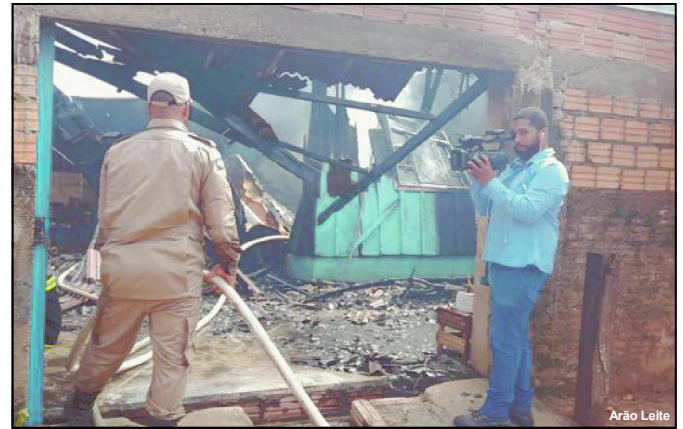
Fogo acabou controlado rapidamente, mas a destruição foi inevitável
