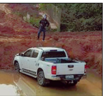
S-10 caiu em local onde será construída galeria pre-moldada
