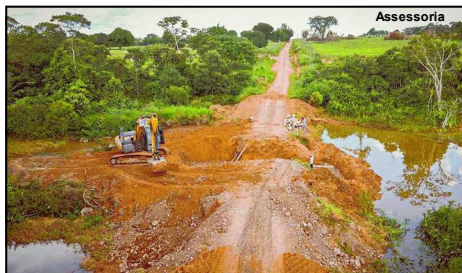
Obra em execução na vicinal em Alta Floresta
