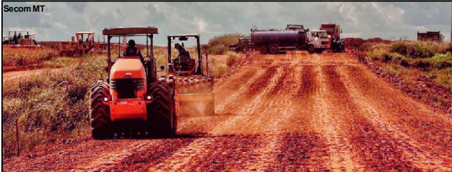
Obras de pavimentação da rodovia MT-130, em Santiago do Norte
