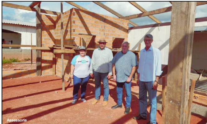
Visita da obra executada na zona rural
