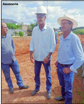
Vereador Pitoco acompanha início da obra de pavimentação asfáltica no bairro Cidade Bela
