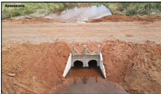
Aduelas substituem estrutura de madeira
