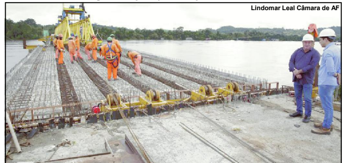
Vereador presidente da Casa Leis no canteiro de obras
