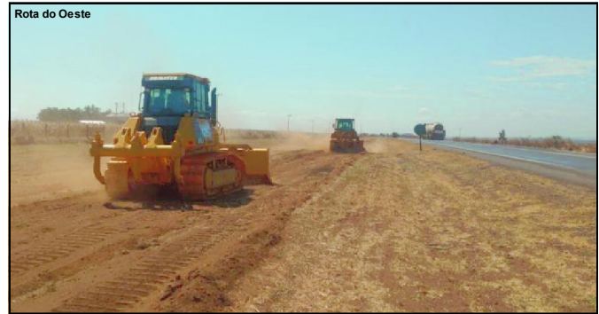
Rodovia federal em Mato Grosso será duplicada e a obra tem como foco melhoria do tráfego
