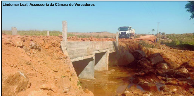
Execução de obra na zona rural de Alta Floresta
