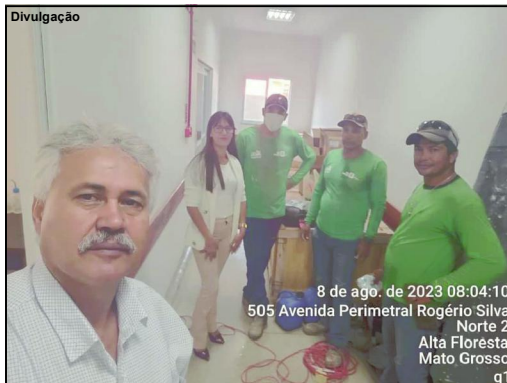
Naldo e Leonice visitando a obra em AF
