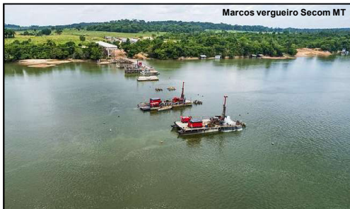
Ponte em construção no Rio Teles Pires pela MT-419 interligará Novo Mundo ao Município de Carlinda
