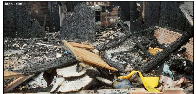
Residência de madeira virou escombros
