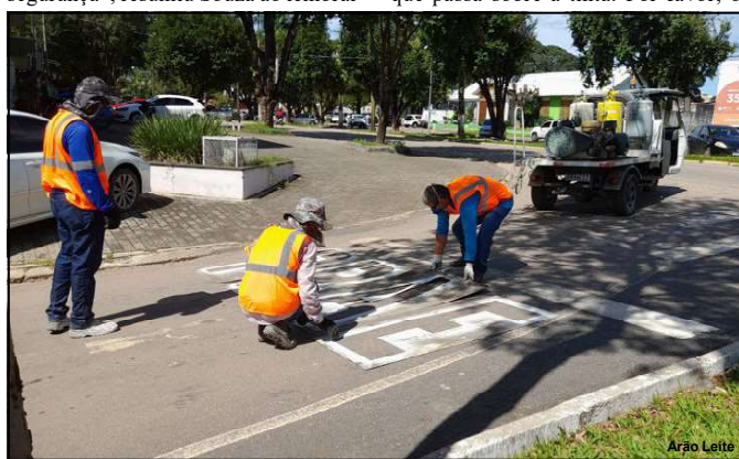
Obra executada na região central de AF
